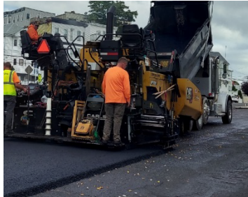
Repavimentación de las secciones dañadas de las carreteras
