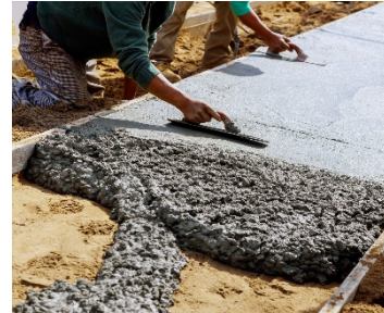
Reparación de aceras
