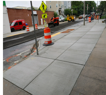
Reparos das calçadas
