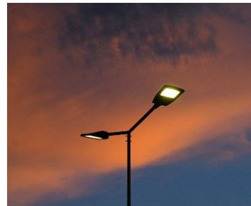
Melhoramento da iluminação pública
