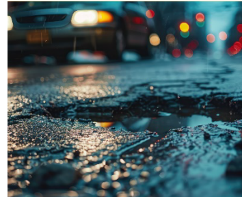
Reparo de buracos
