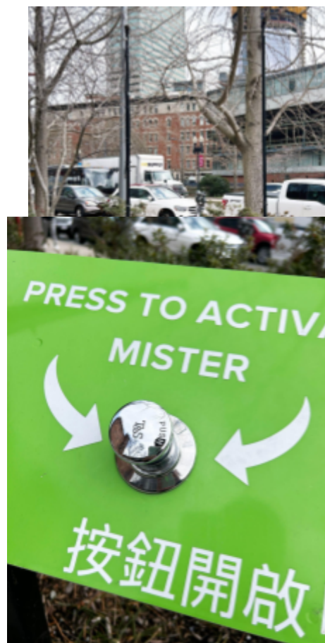
Пример дозирующего водяного клапана. Этот тип клапана настроен на подачу воды в течение определенного времени, что исключает риск оставления воды включенной.
