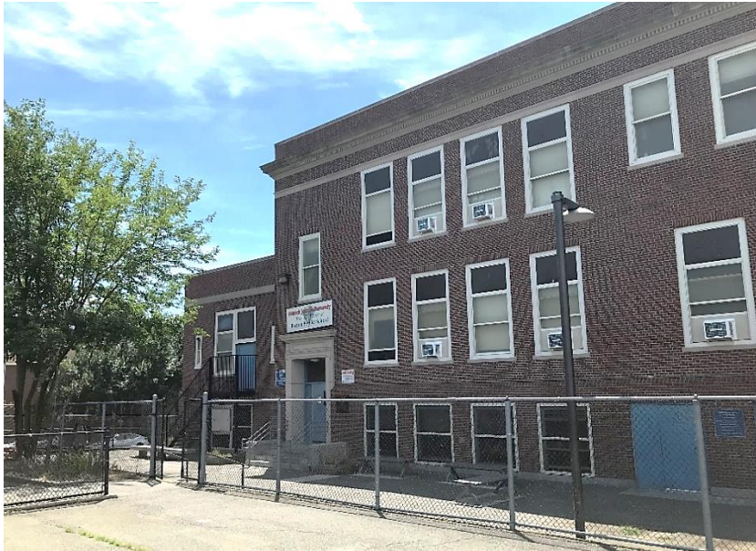
EXISTING (Edificio actual)
