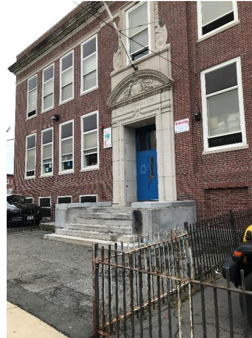
TEMPORARY MAIN ENTRANCE AT SARATOGA STREET UNTIL THE ADDITION IS COMPLETE (SEPT. '25) (ENTRADA PRINCIPAL TEMPORAL EN LA CALLE SARATOGA HASTA QUE SE COMPLETE LA ADICIÓN.) (SEPT. '25)
