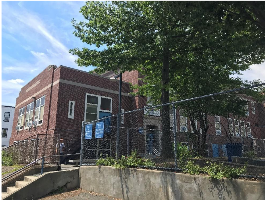
EXISTING (Edificio actual)
