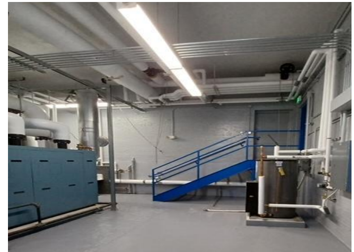
Boiler Replacement Photos (Fotos del reemplazo de la caldera)
