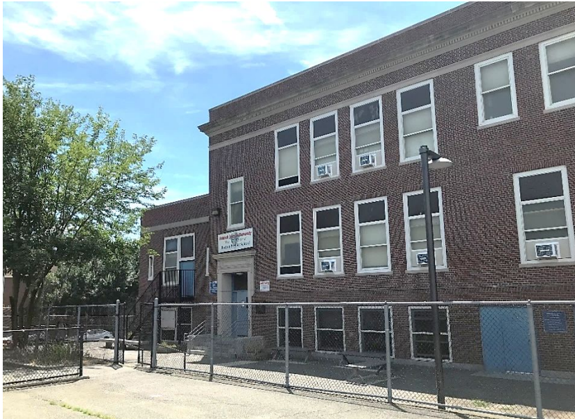
EXISTING (Edificio actual)
