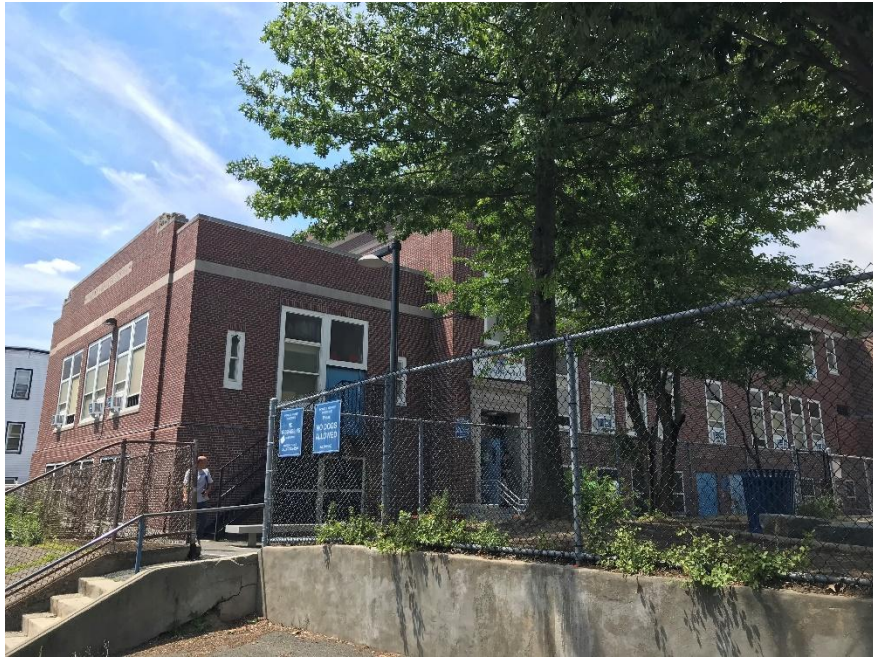
EXISTING (Edificio actual)
