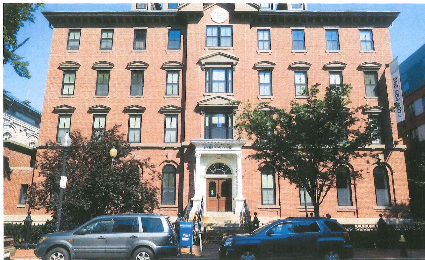
1 Existing Façade N.T.S.
