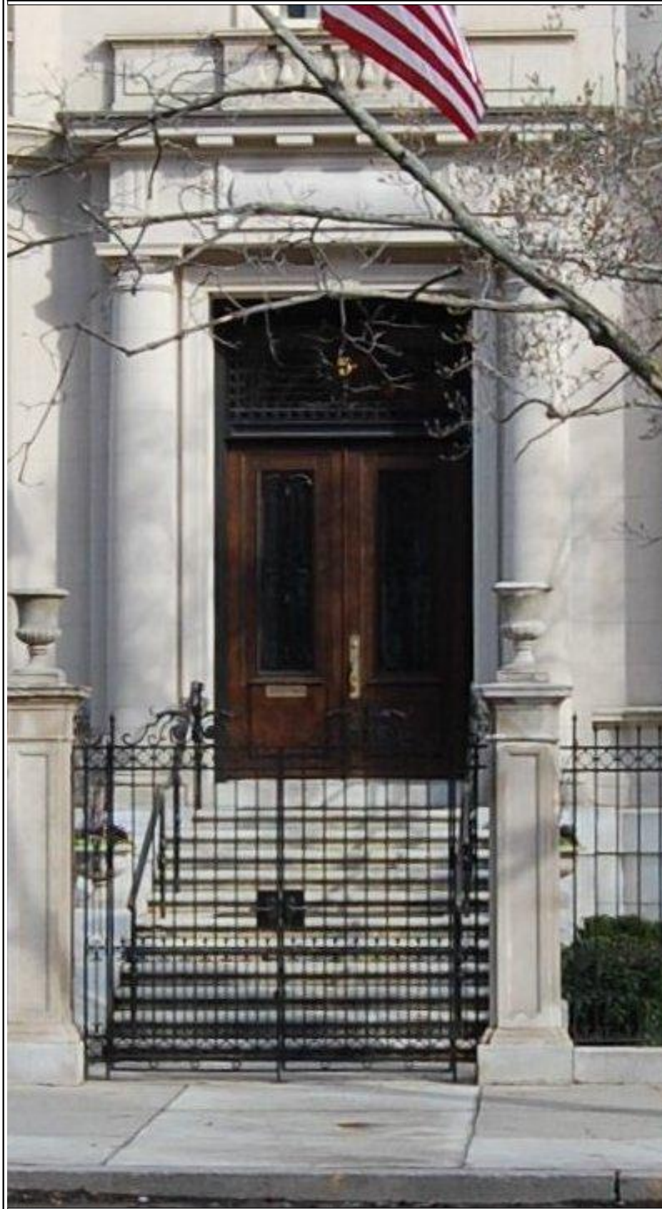
5 COMM. AVE. ORIGINAL DOOR
